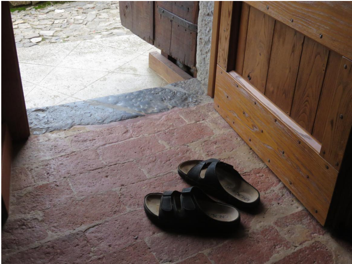
Détail de l'entrée de la cuisine. Catelles terre cuite restées telles qu'à l'origine. Porte extérieure originale, porte intérieure en châtaignier de fabrication artisanale d'un professionnel de Ubiale, à quelque 12 km de là.
