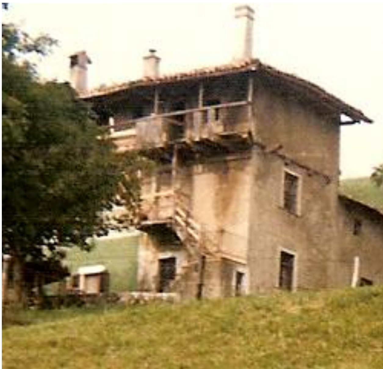
La maison avant tous travaux, photo de 1986.
