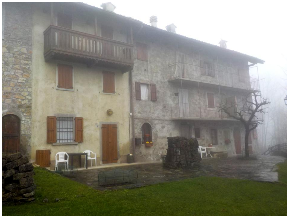
Ce tas de pierre témoigne encore de l'emplacement où était l'angle de l'appentis.
