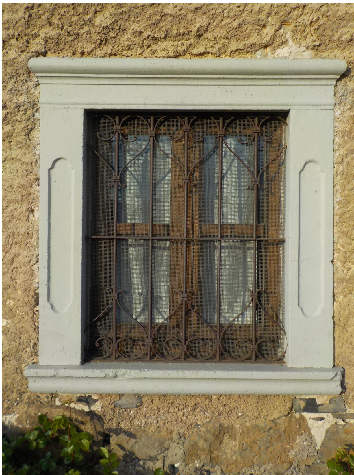
Fenêtre de l'extrême droite. Datant des années vingt environ.
