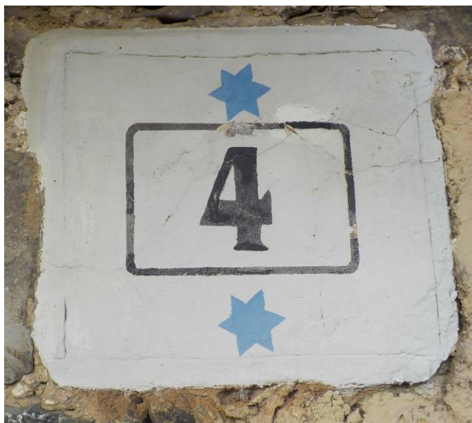
Ancien numéro de maison qui était presque entièrement disparu. Restauration et modification selon nos soins.
