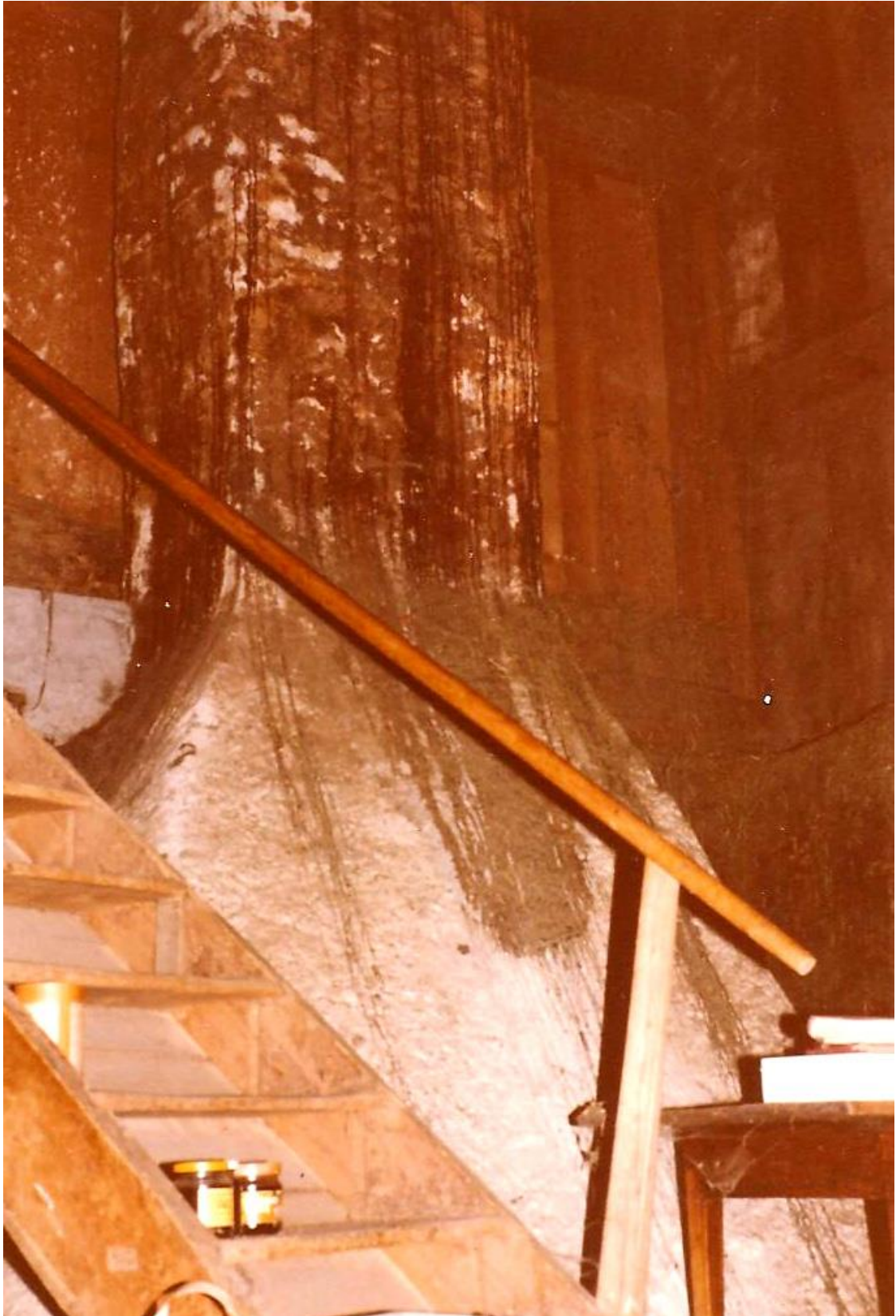
Cette cheminée, autrefois en bois, transformée sans doute au début du XXe siècle, est un monstre. Elle doit peser plusieurs tonnes.
