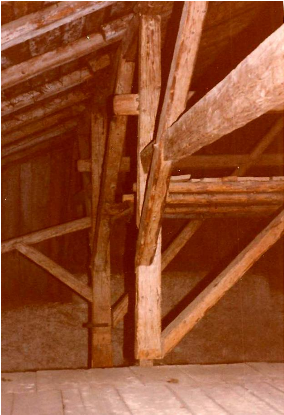
La magnifique poutraison du galetas.
