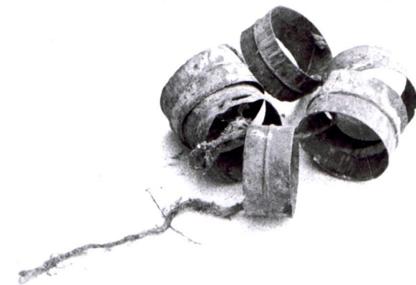
Les boîtes pour le raccord des tuyaux d'eau en bois.
