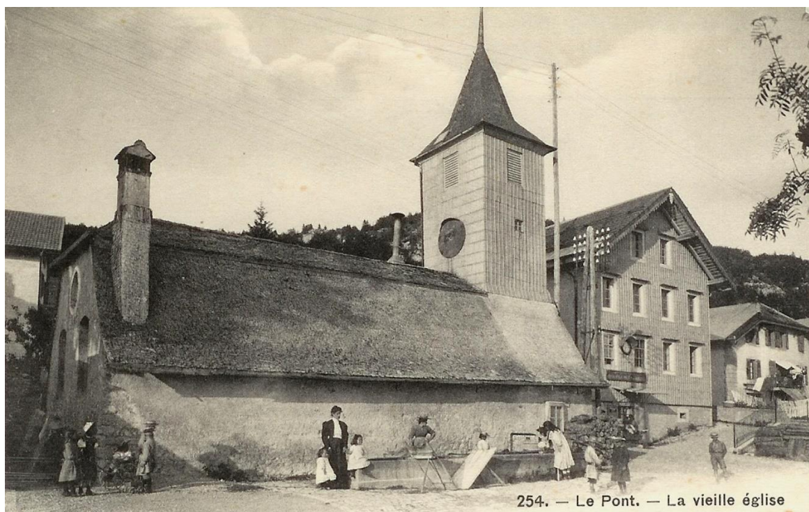
Des lavandières aussi au Pont, à la fontaine de l'église.
