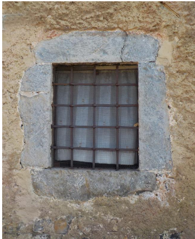
Fenêtre à l'ancienne avec pierre de taille et grille de protection, comme toutes les fenêtres placées au rez des maisons. Maison Pelac.
