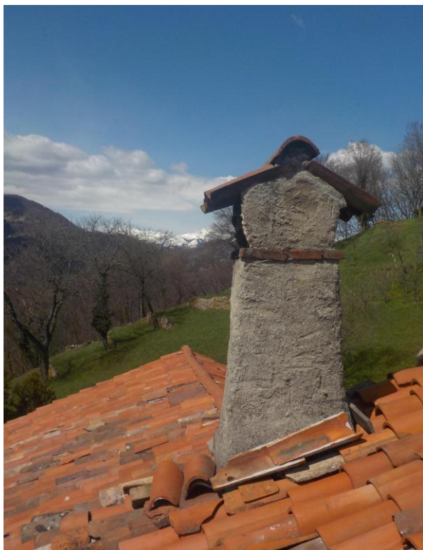
Type de cheminée ordinaire. Maison Carminati.
