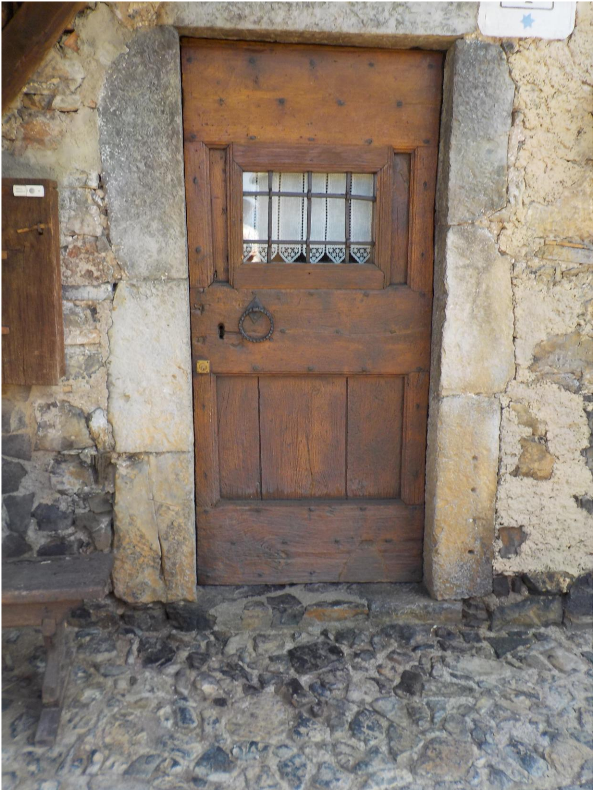
Porte d'entrée. Maison Pelac.
