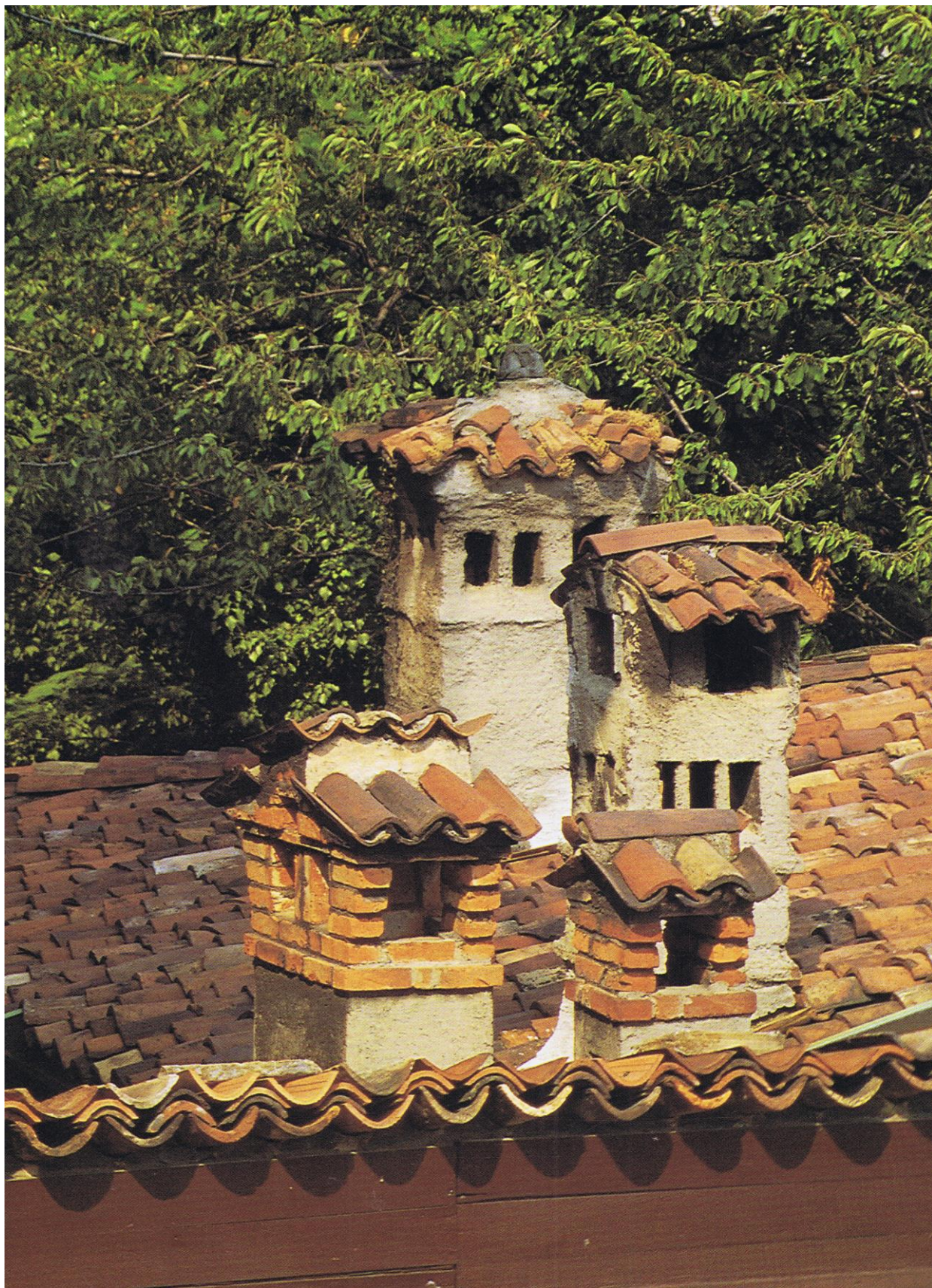
En un autre lieu ensemble de cheminées très complexe. Amare, 1996, p. 165.
