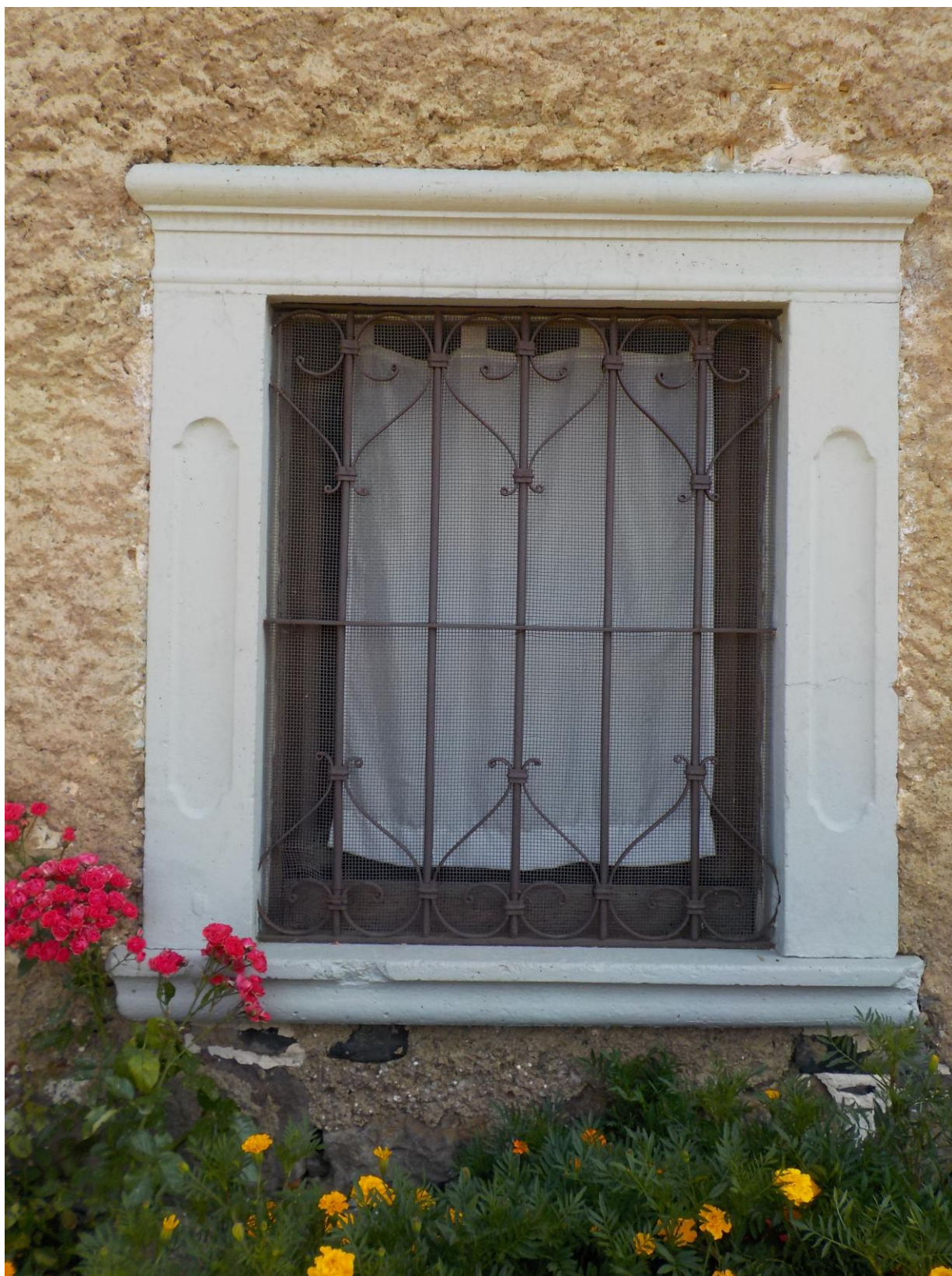
Fenêtre en ciment ayant remplacé une ancienne fenêtre plus modeste sans doute en pierre de taille. Maison Pelac.
