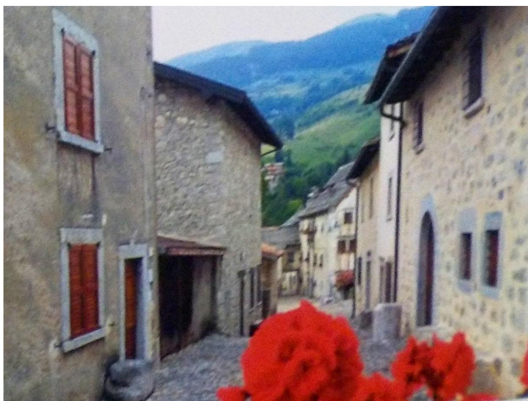
Rue principale après restauration.
