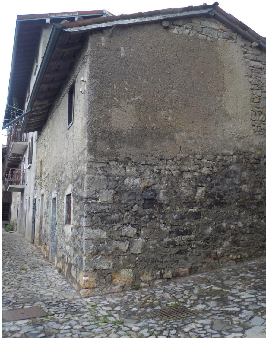
Le bâtiment devenu musée. En haut la grange, en bas l'écurie.
