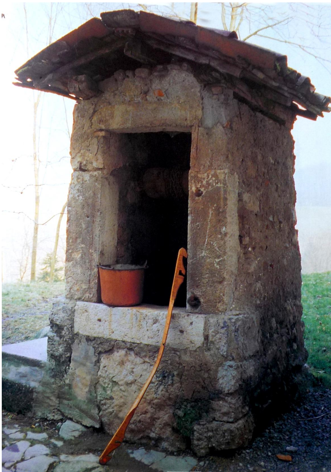
Le puits présente parfois l'aspect d'une petite maison. Amare.
