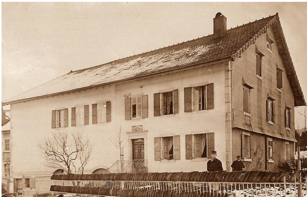
La maison Saïset vers 1920. Le panneau au-dessus de la porte d'entrée annonce le téléphone public. Des fonds à vacherin sèchent sur la barrière.
