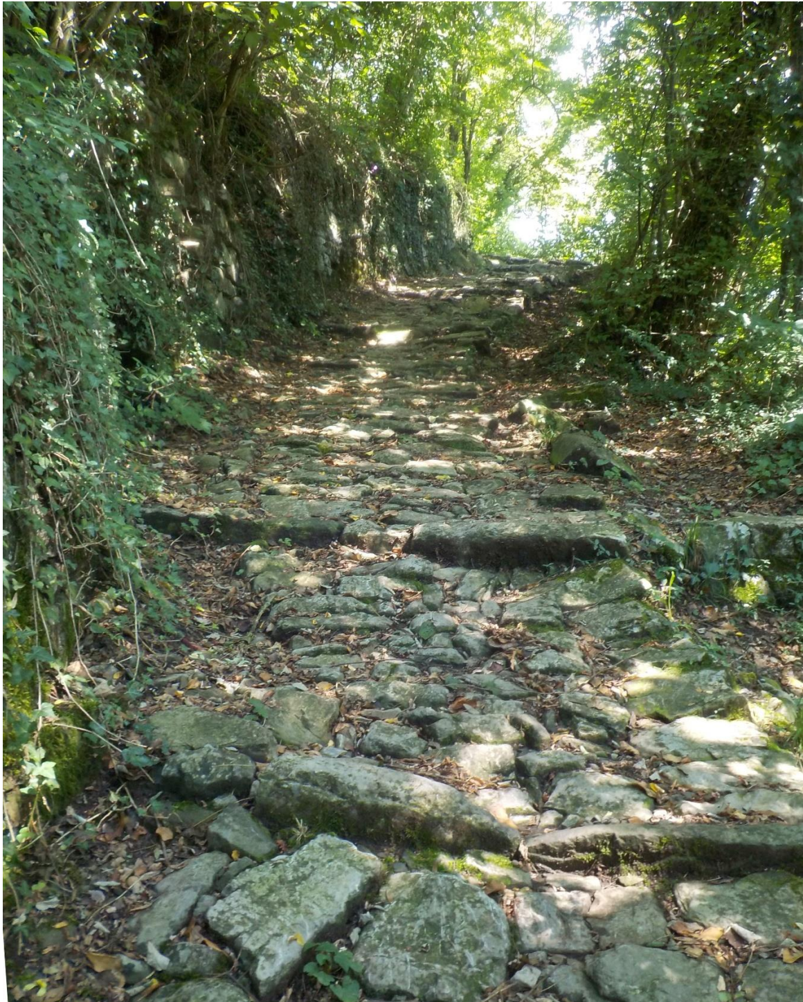
Chemin muletier en dessous de Cerro.
