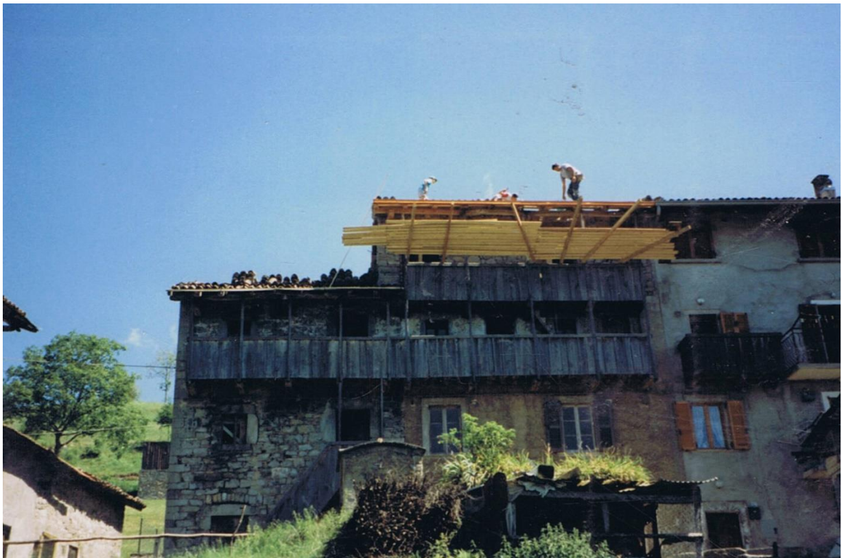
Réfection d'un toit à Gaiazza vers 1990.
