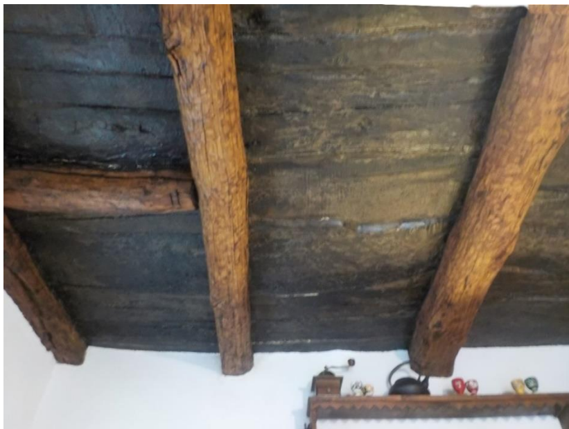
Plafond d'une vieille cuisine de Gaiazzo. La suie est sur toutes les planches. Elle l'était aussi sur les poutres qui ont été restaurées.
