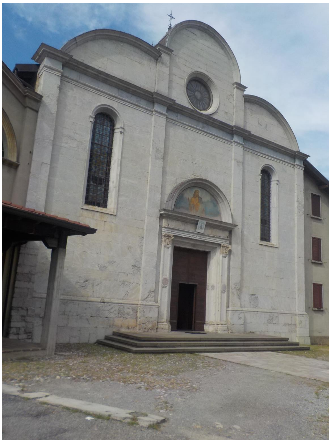
Façade principale de l'église.
