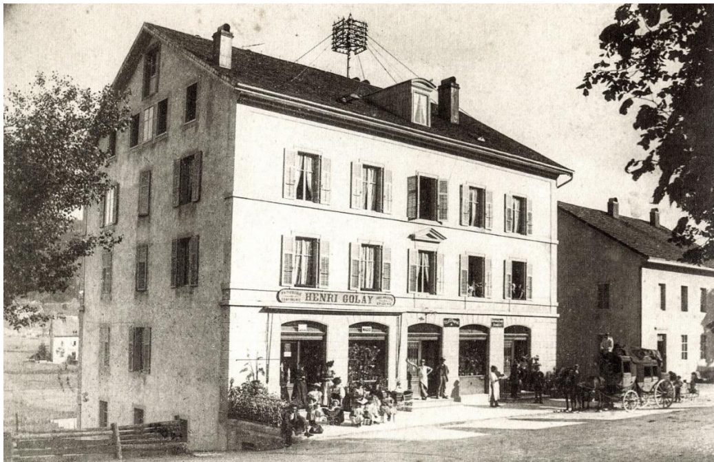
Poste du Sentier. Nous sommes entre 1900 et 1920. La diligence, partie du Pont, arrive à la capitale. Sur le toit la distribution des fils téléphonique.
