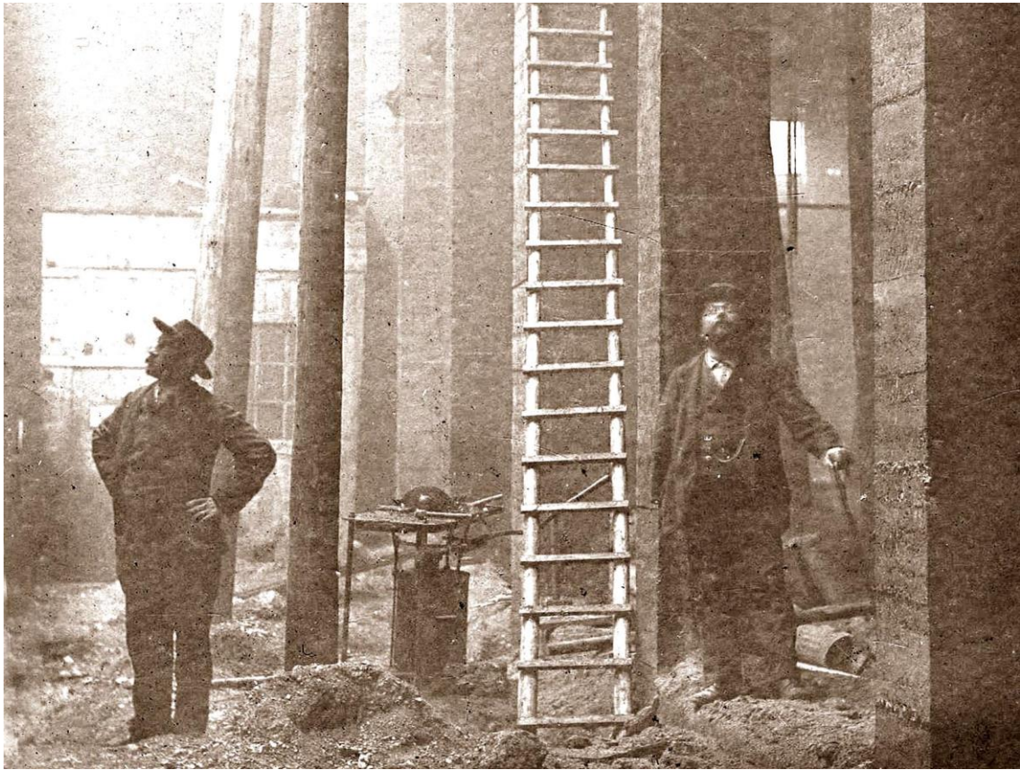
Intérieur des glacières dans un entrepôt vide. Les perches qui aident à soutenir les toits, ont environ 7 à 8 m de hauteur.
