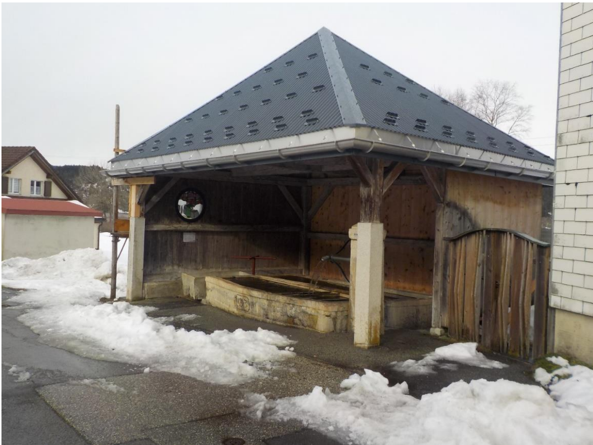
Restauration du toit de la fontaine du bas à L'Abbaye et installation du vitrail de la Lavandière par l'association du Chemin de St. Norbert.
