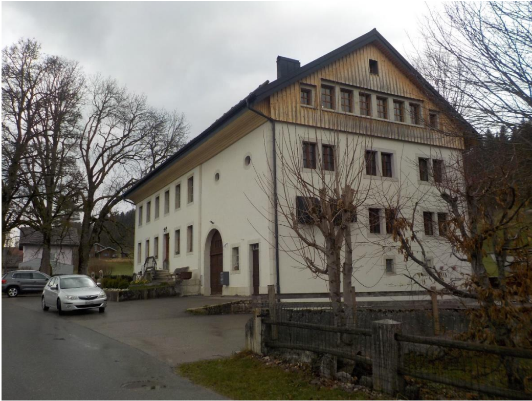
Maison Candaux, au Solliat, avec atelier entièrement restauré sous les combles.
