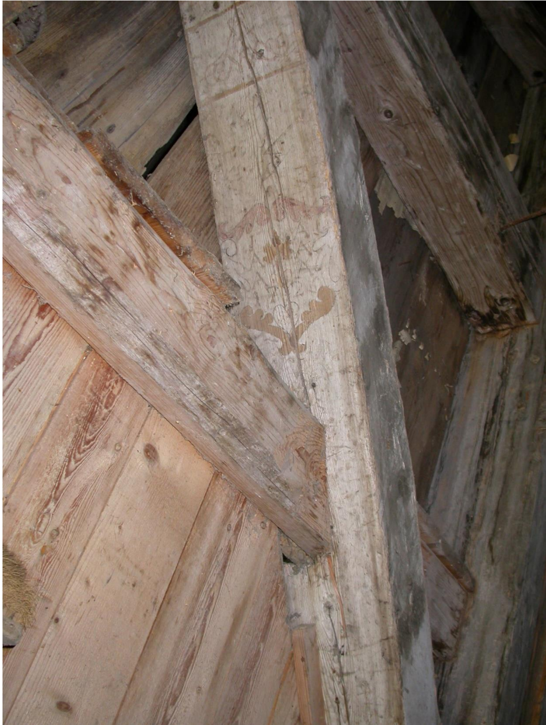
Inscription sur l'une des poutres du néveau. 1720. Trois siècles bientôt. Cela fait une paie !
