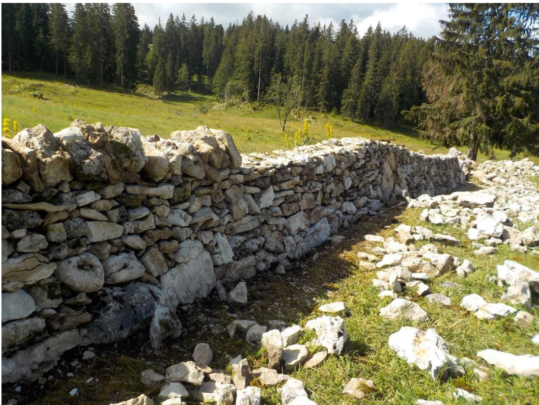
Mur en reconstruction sur l'alpage de la Muratte en 2020.
