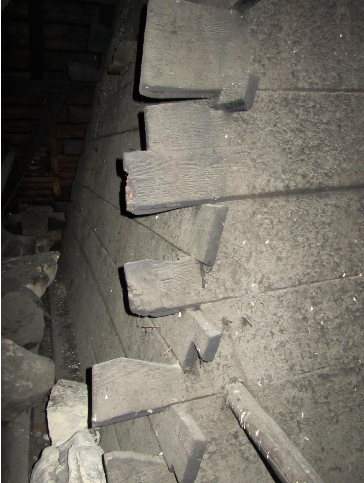
La manière exacte dont les planches de la cheminée sont enchevêtrées.
