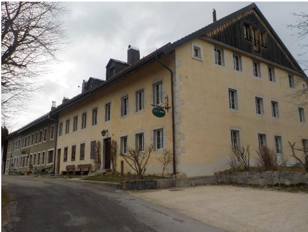
Chez les Aubert, Derrière-la-Côte, fenêtres au troisième niveau à bise du bâtiment.
