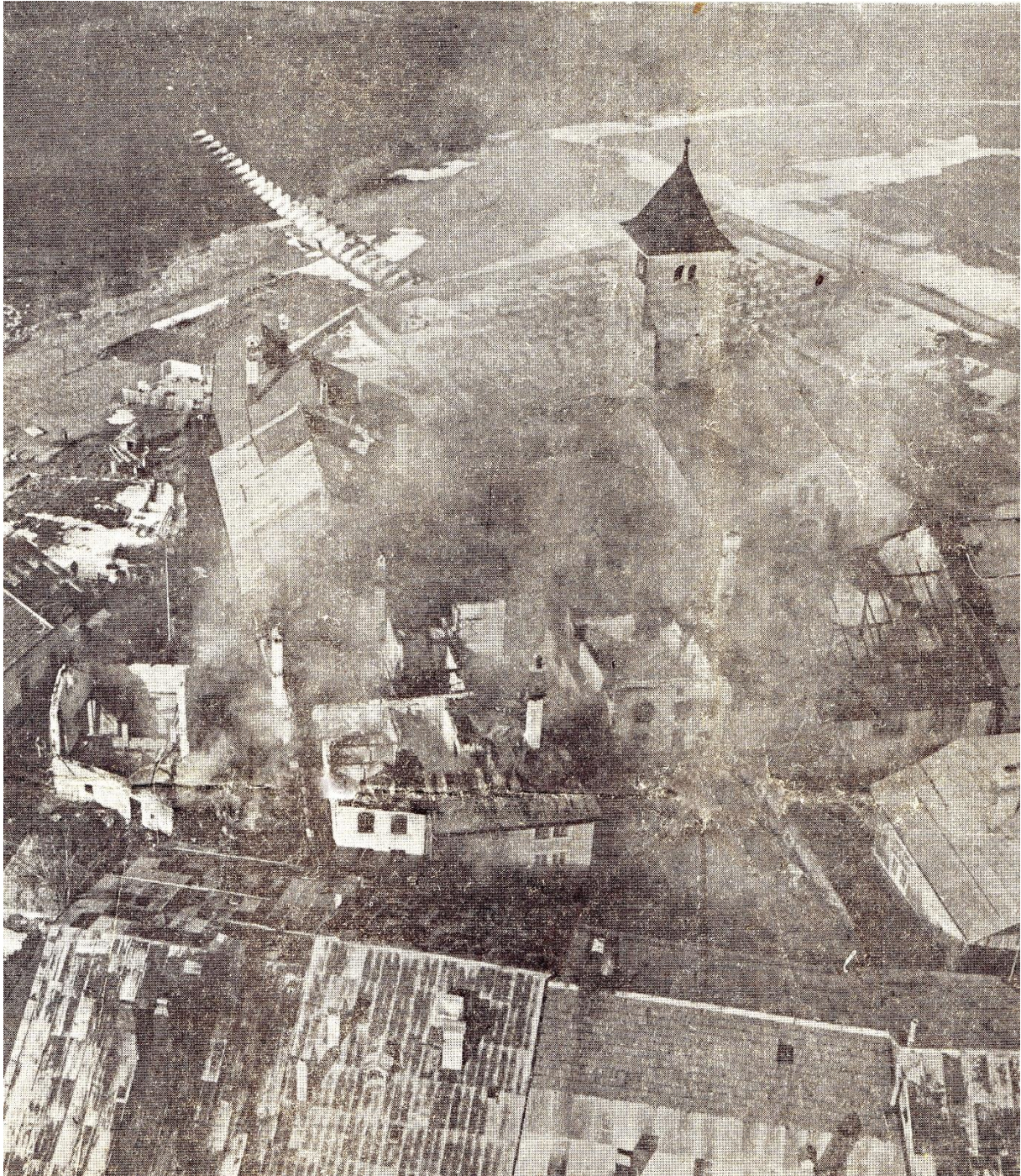
Le vieux village de l'Abbaye, établi sur le couvent après le départ des religieux, avec des modifications importantes en vue de constituer des maisons habitables, reste difficile à reconstituer « photographiquement », faute de documents en nombre. Le sinistre est du 25 février 1966. Photo aérienne prise par la FAL le lendemain ou surlendemain de l'incendie.
