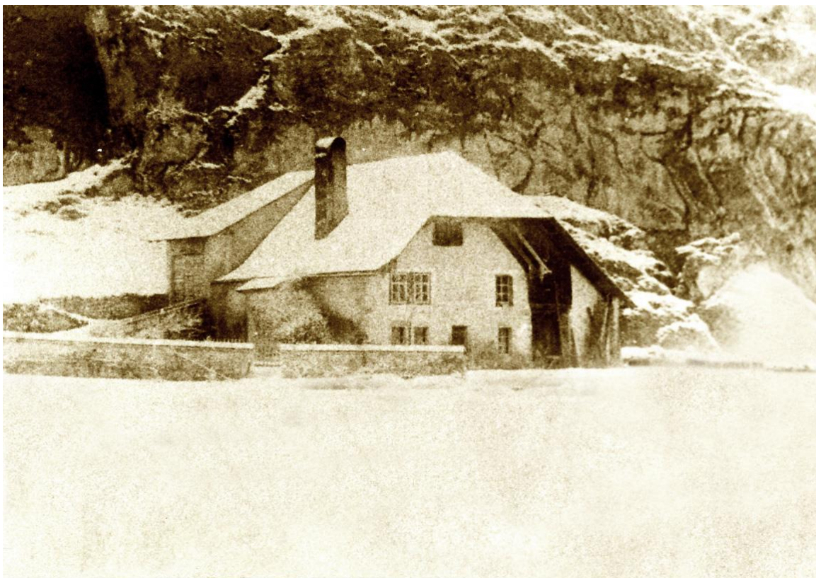
Bonport, maison d'habitation et ferme détruits par l'incendie du 17 décembre 1898. La maison était jolie, avec son style quelque peu du nord vaudois.
