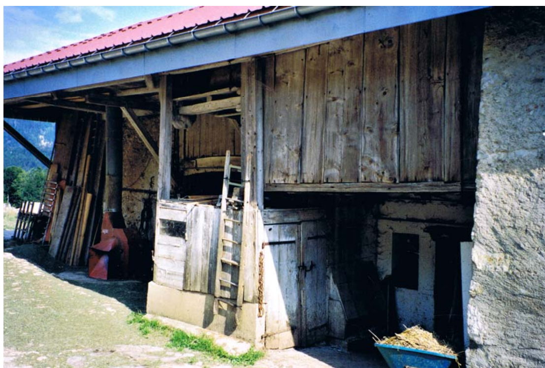
Néveau arrière de l'Epine-Dessous. Il date de 1780, alors que l'on construisait la maison sinistrée.
