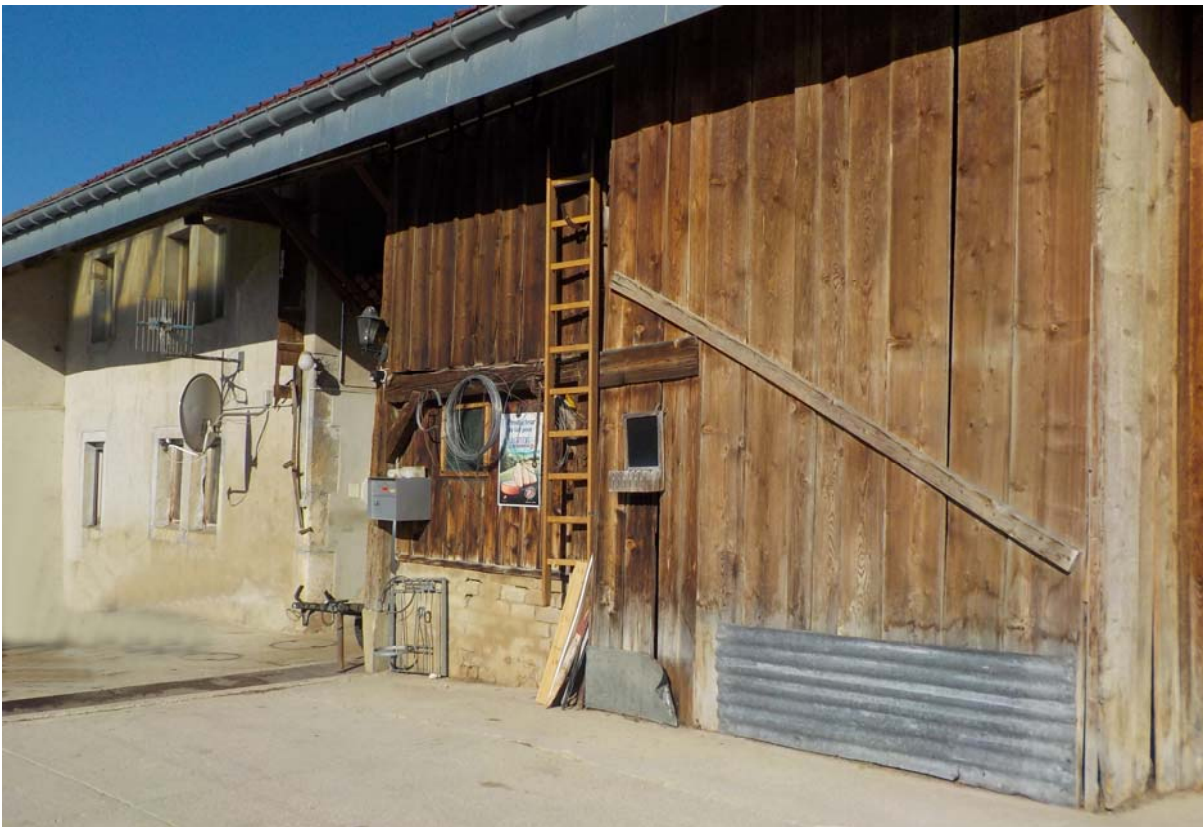
L'Epine-Dessous de vent le 30 mars 2021, à 10 heures. Derrière les planches de gauche, le néveau et la porte de grange.
