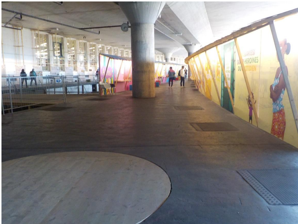
Des piliers monstrueux soutiennent des dalles elles aussi monstrueuses.
