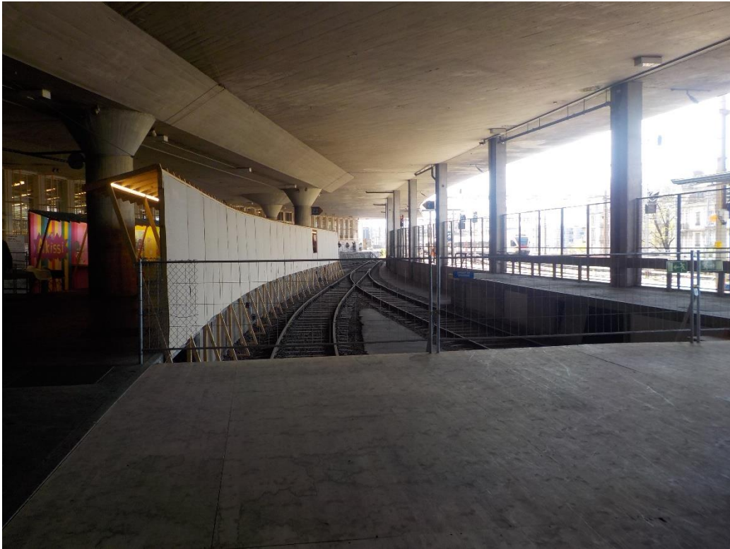
Du béton et des lignes de chemin de fer.
