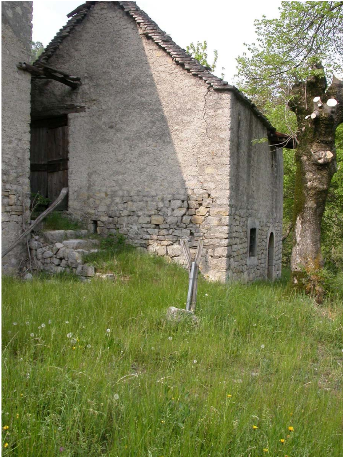
Une belle écurie au bord du chemin retiendra toujours notre attention. Le toit ici est en pierre.
