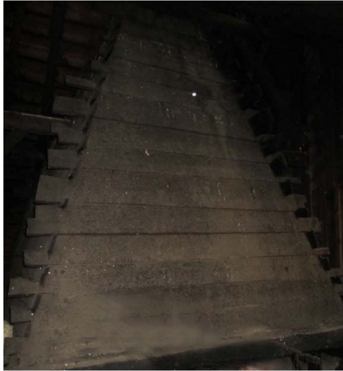
Magnifique cheminée de bois, avec, bien visible, la manière dont étaient assemblés dans les angles les différents éléments de construction.
