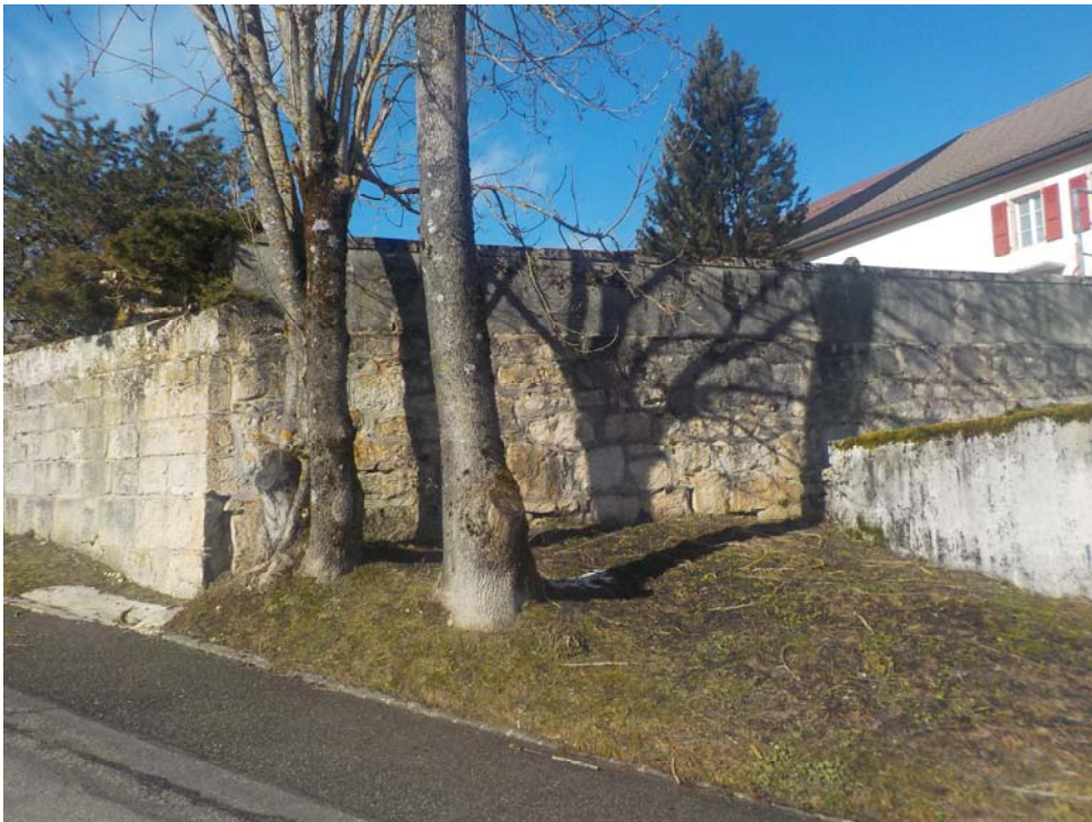
De beaux cailloux pour contenir le terre-plein de la maison.
