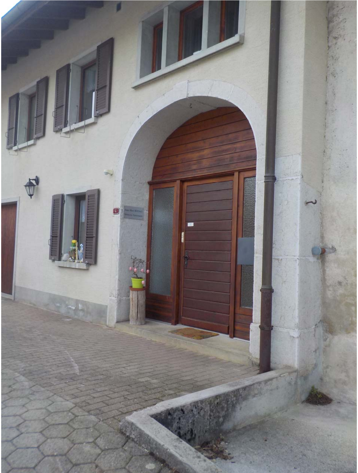
Une magnifique pierre de taille pour une belle restauration générale.
