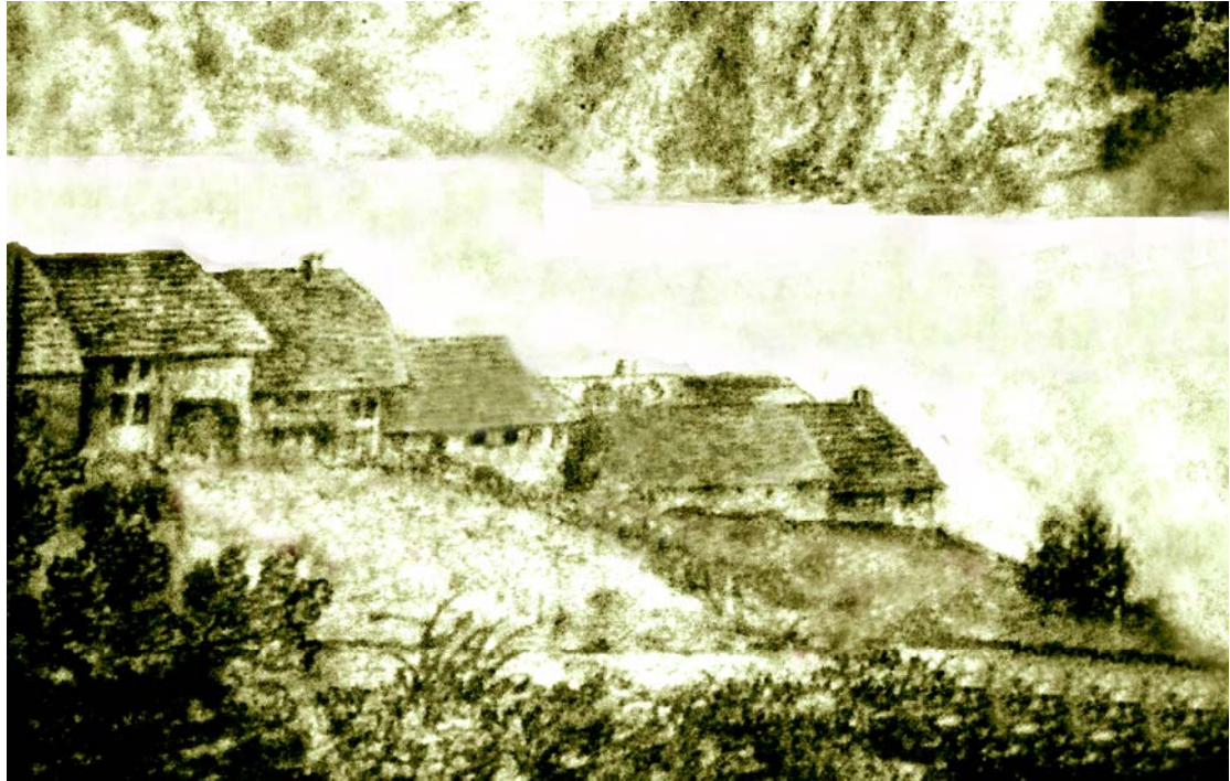
Une gravure ancienne, vers 1830, nous révélant les maisons étagées du quartier du Cygne. Les maisons du centre correspondent à celles dites Là-Dessous. Les néveux restent d'actualité.
