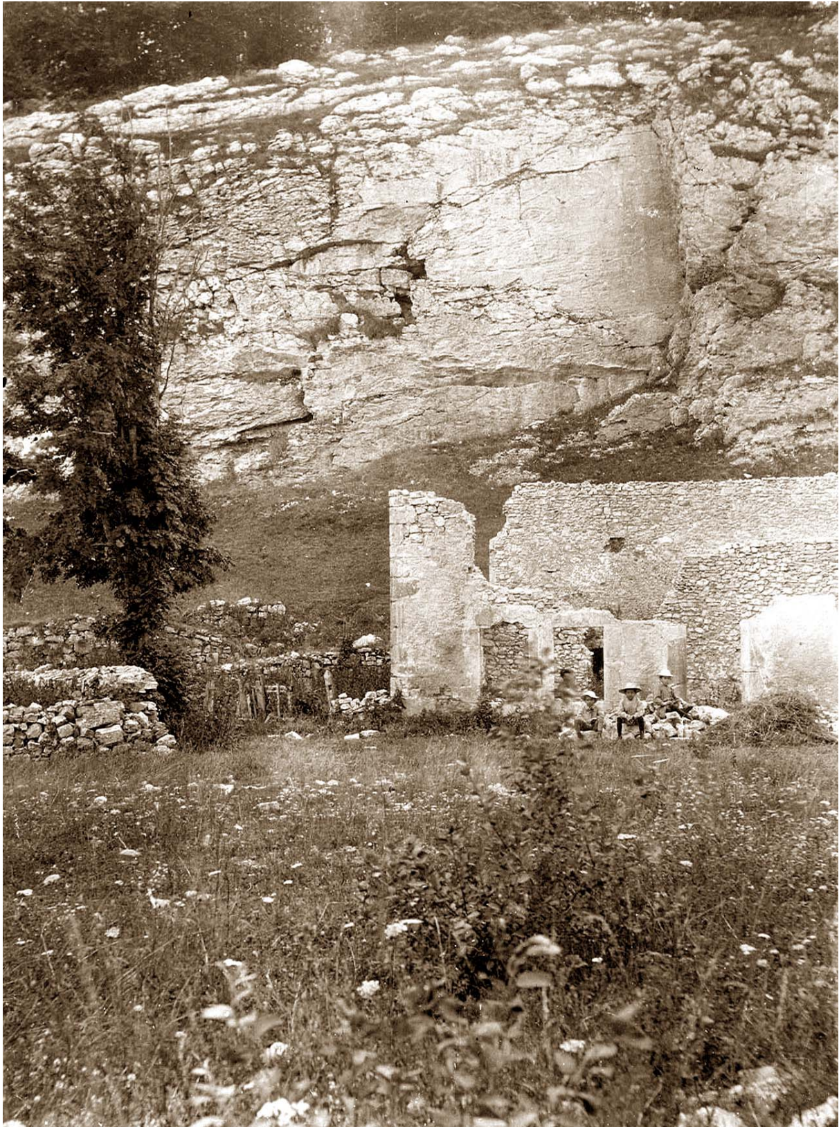
La maison de Bonport, là où est née Eva, arrière-grand-mère, en ruine. Photo de René Meylan. Il est très certain qu'elle aura servi de carrière pour la construction de quelque maison du village des Charbonnières.
